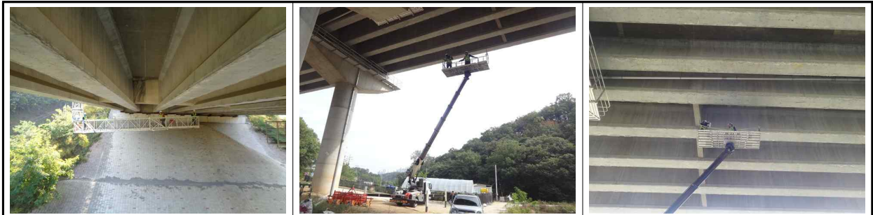
[고소작업차, 굴절점검차를 이용한 근접조사 실시]
