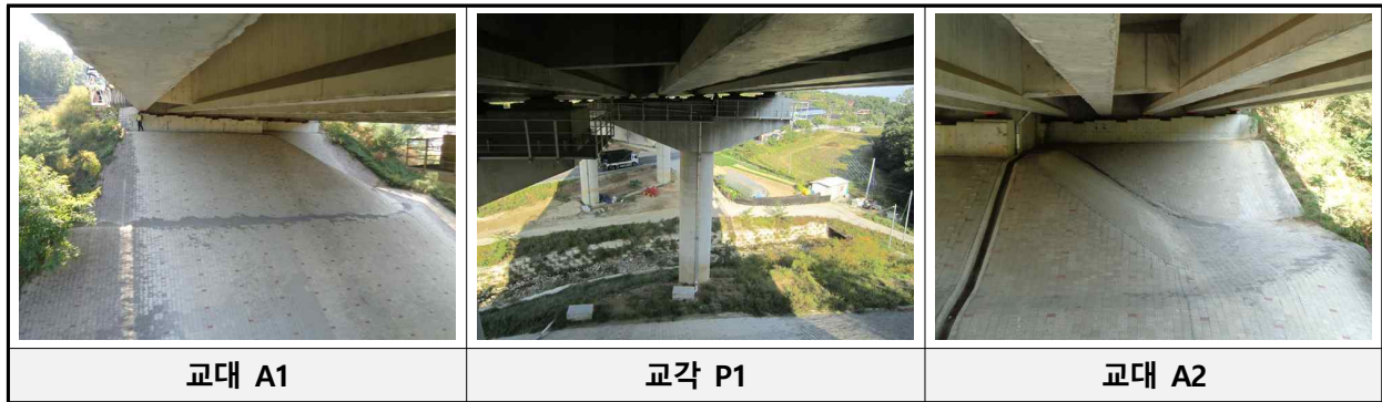
[교대 및 교각 전경]
