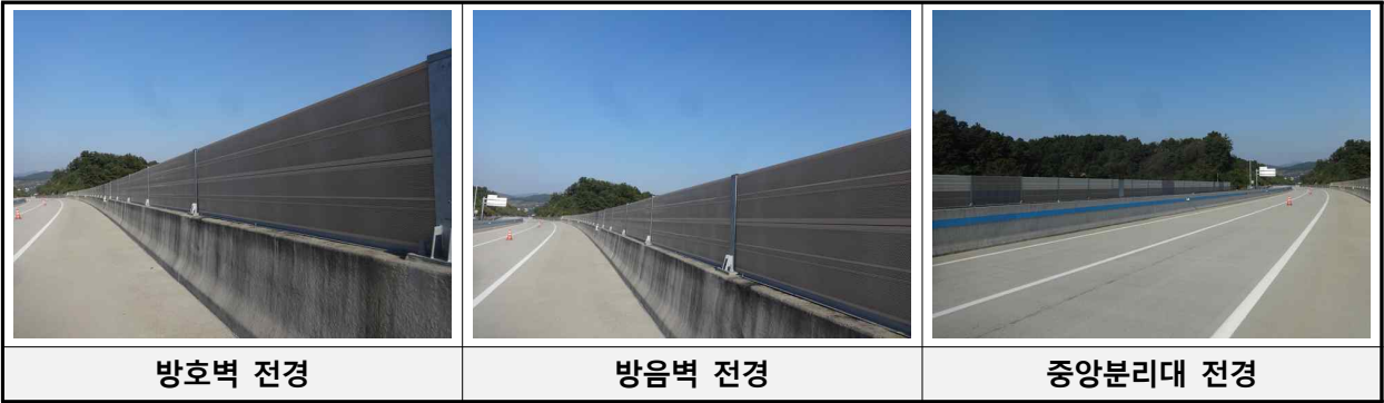
[방호벽 및 방음벽 전경]
